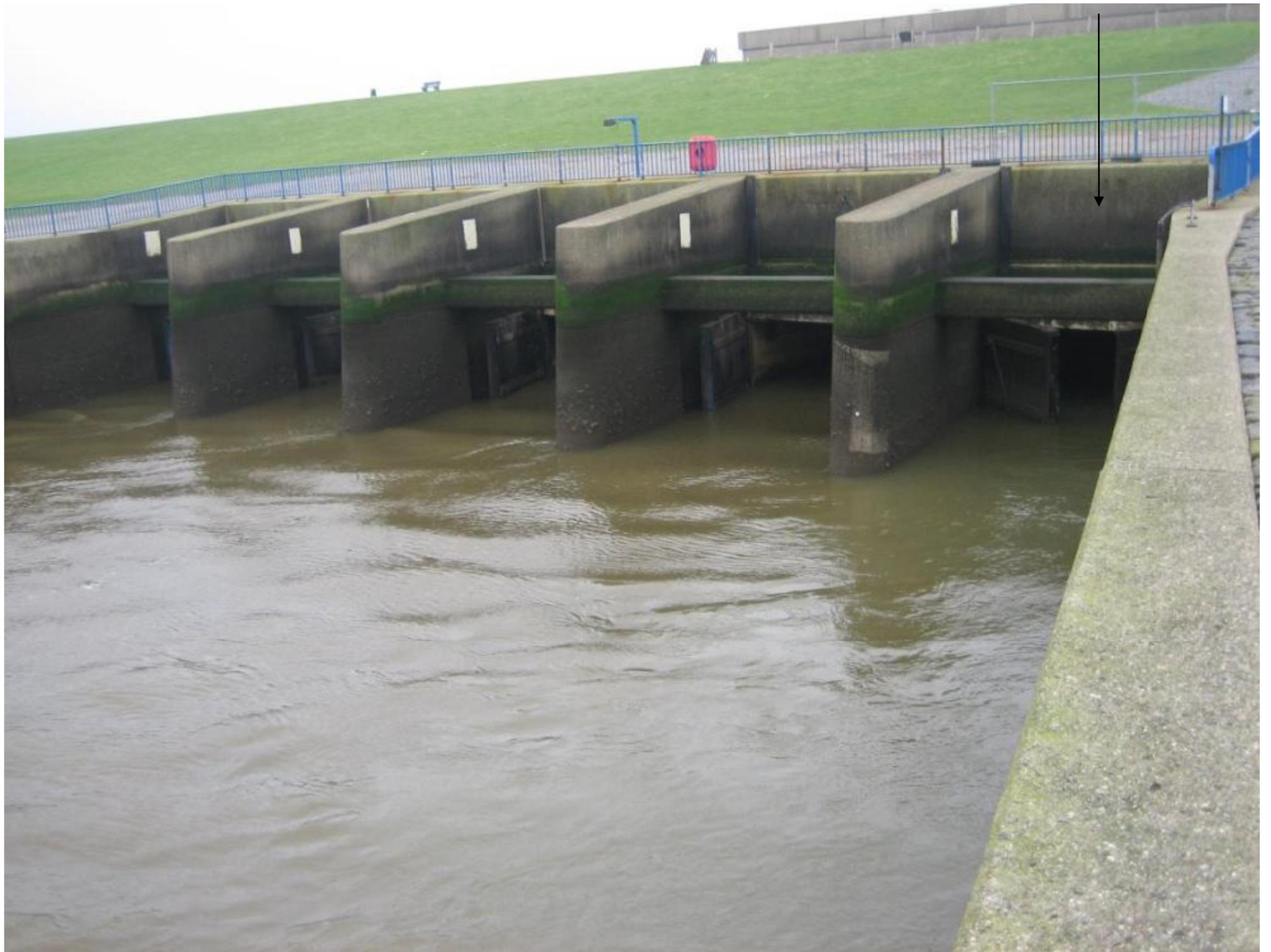
***Ein Siel ist ein verschließbarer Durchlass in einem Deich und dient zur Entwässerung des Binnenlandes.***
